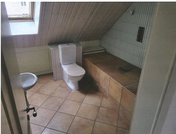
WC séparé, buanderie (sans équipements)
